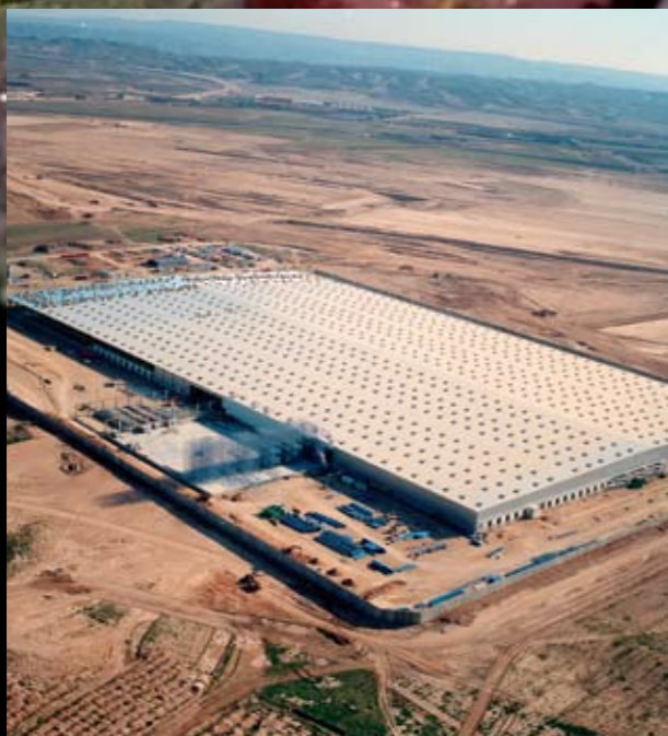
Logistiek centrum Zara (Spanje)
